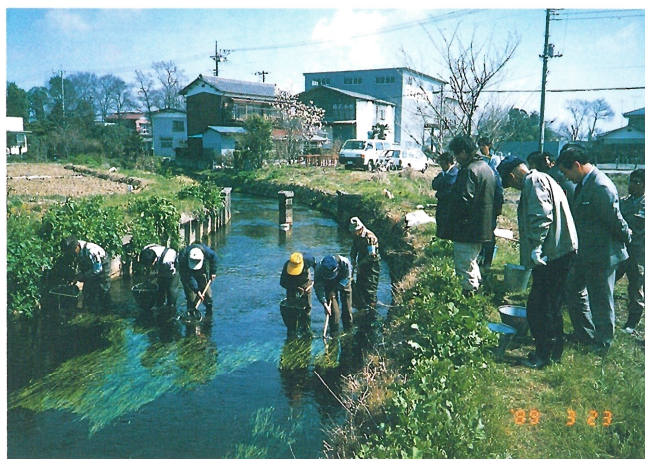
改修工事前の保護採捕 平成元年 3月23日
