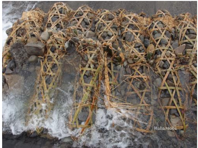
図 13 竹蛇籠魚道の設置
