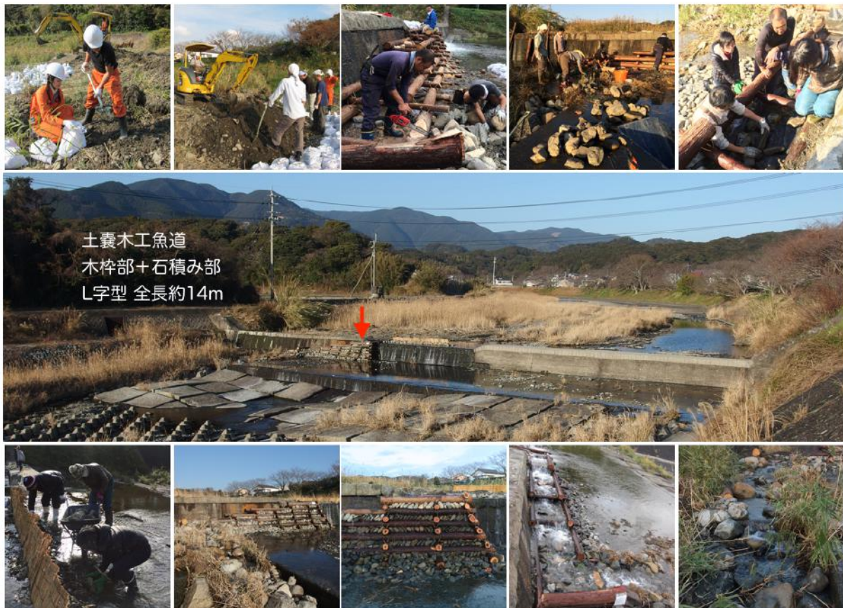
図4 木柵土嚢工法による魚道設置作業状況
