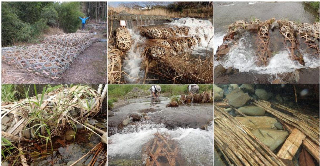
図 14 竹蛇籠魚道の設置状況
