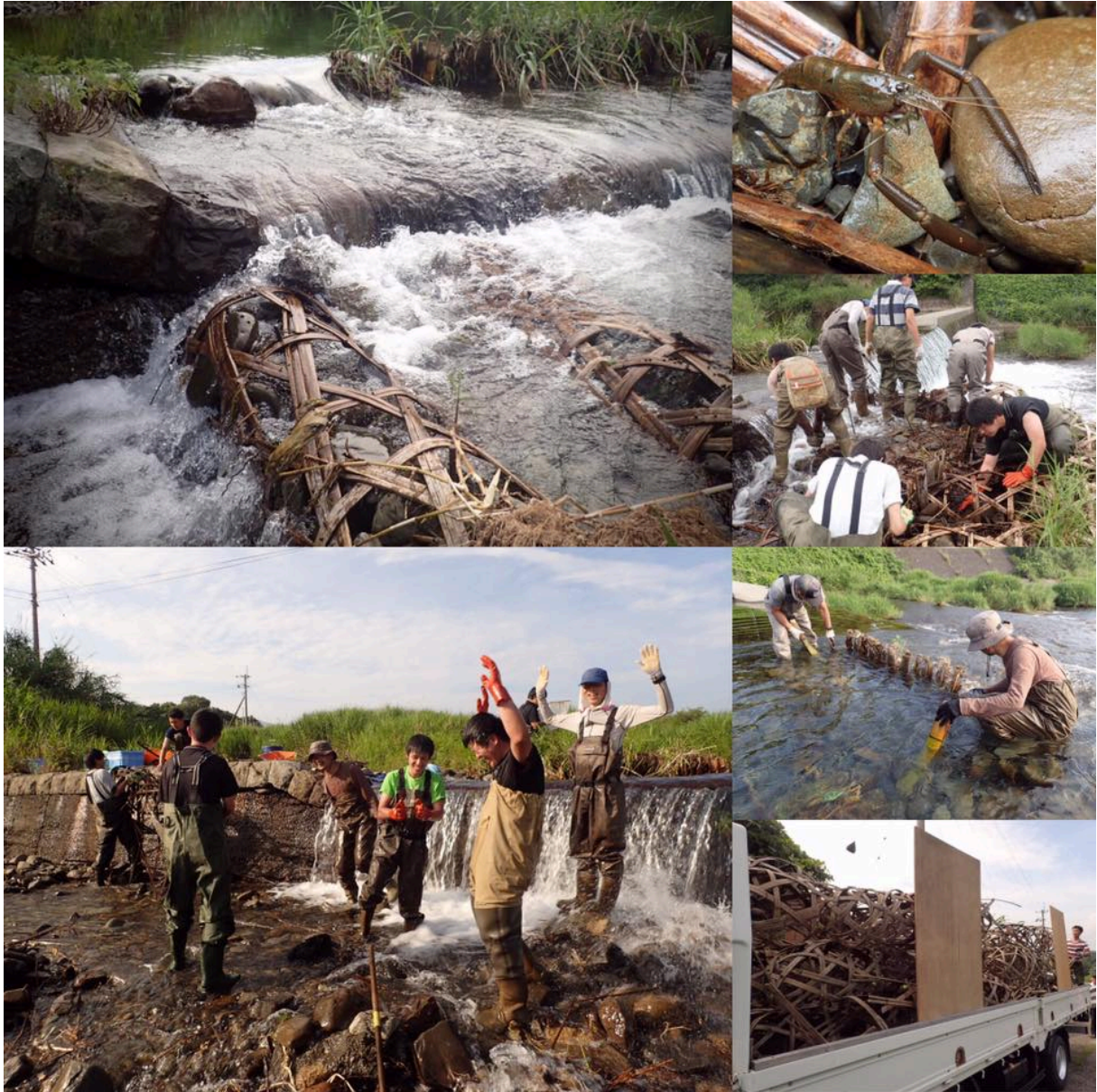
図 16 竹蛇籠魚道 撤去完了
