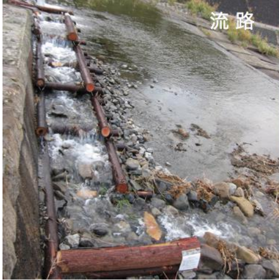
図5 木枠土嚢工法による魚道
