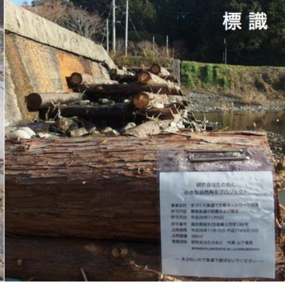
図5 木枠土嚢工法による魚道
