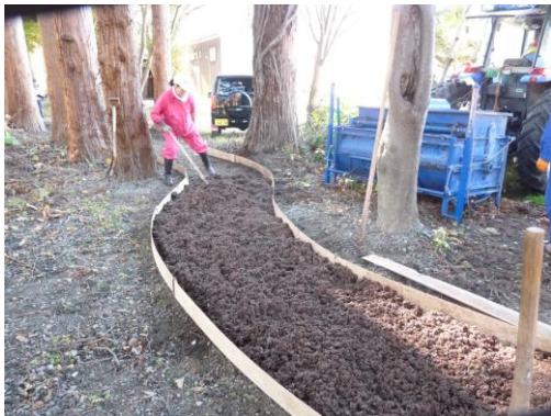
バーク敷き均し
