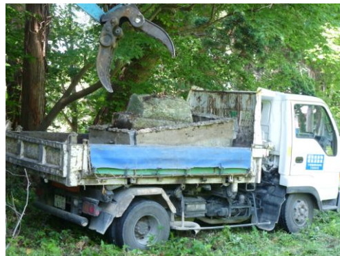
コンクリート殻運搬処理
