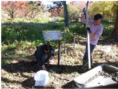
案内解説板設置作業
