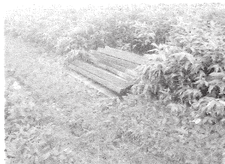
敷設用廃材の仮置き場の一部
