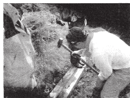
作業風景（杭打ち込み）
