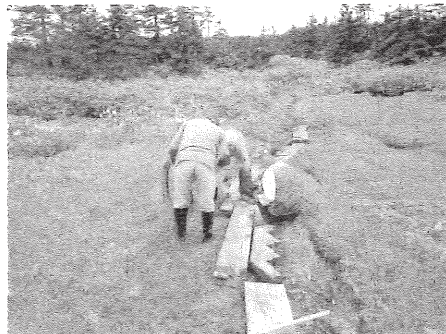
作業風景（廃材の固定）
