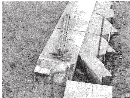
結束した廃材と固定用鉄筋
