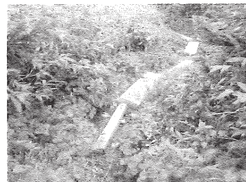
敷設箇所B
