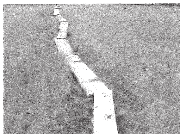
敷設箇所A（約40m）
