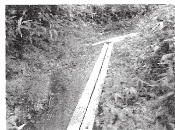
敷設箇所C
