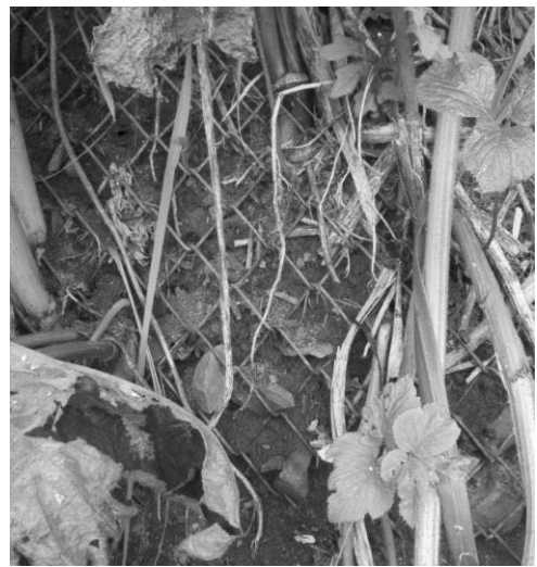
図 30. 崩落防止ネット
