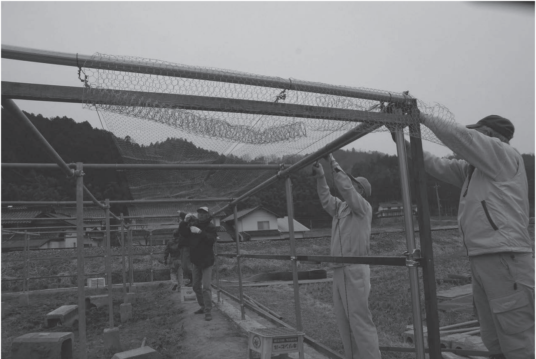
⑦側面と屋根の金網張り
