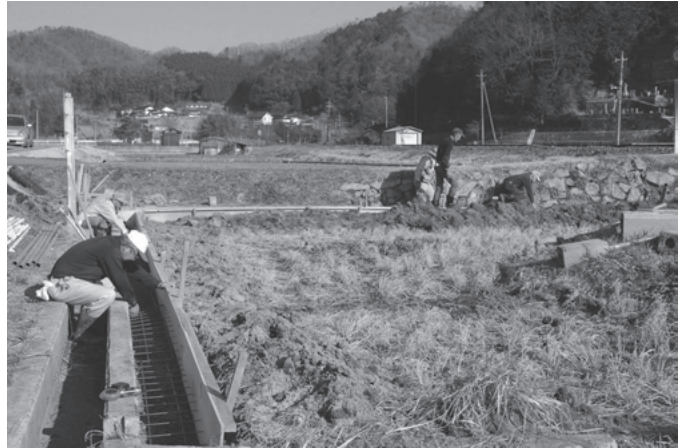
③基礎の型枠
