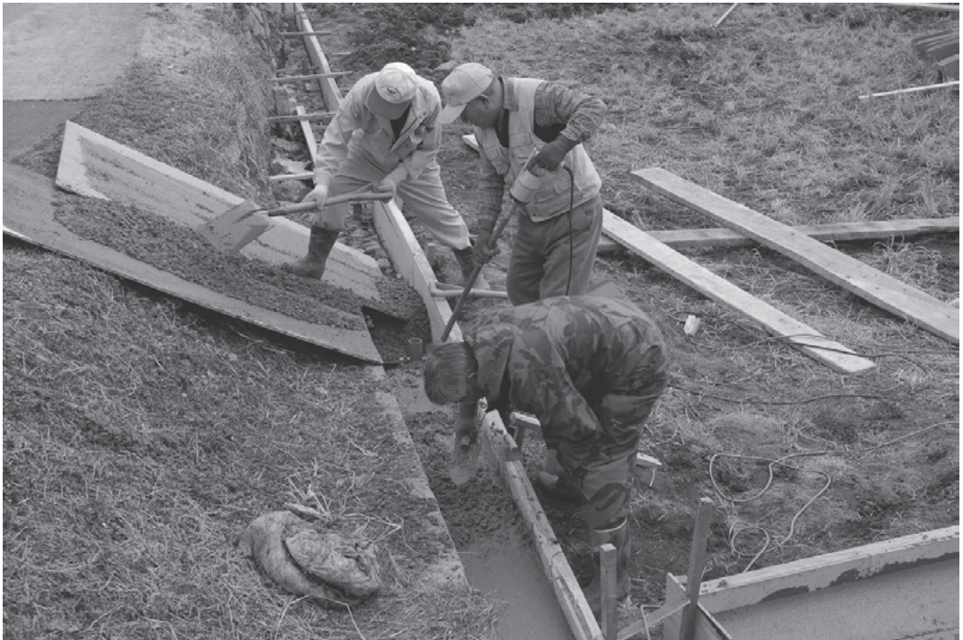
④基礎のコンクリート打設
