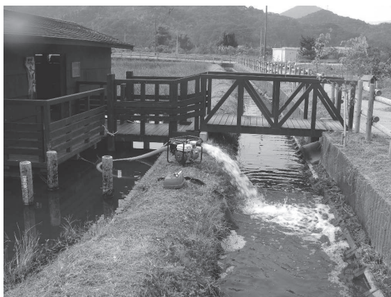
ポンプによる強制排水（平成 22 年 10 月 20 日）
