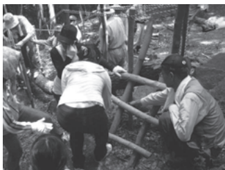
写真16 丸太渡りの建設
