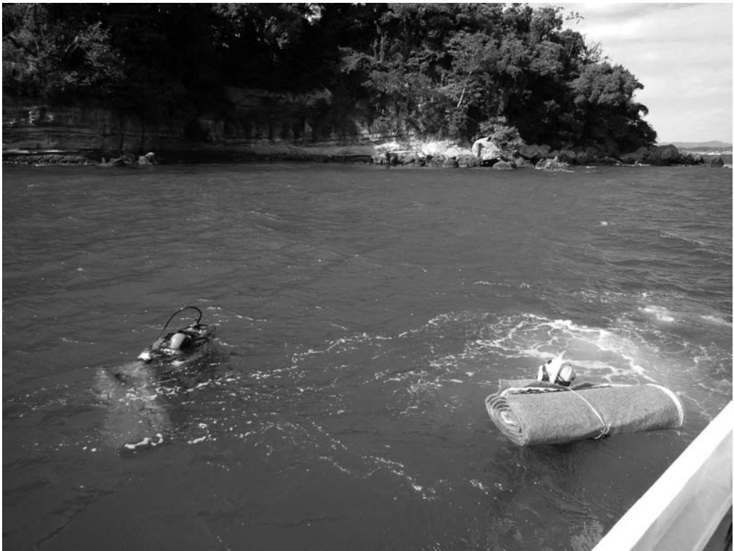
ダイバーによりアマモシートを海底へ設置 2009・11
