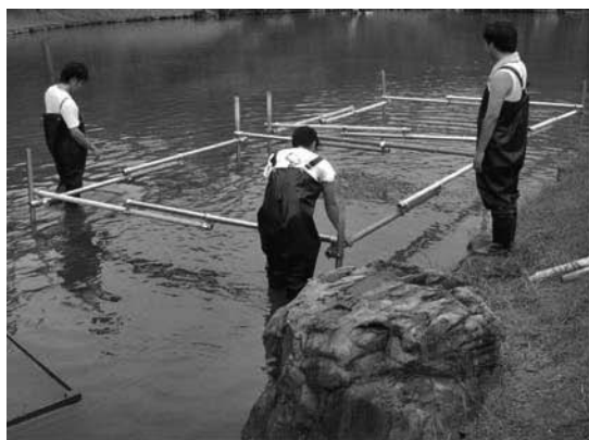
図 1 鋼管で生け簀の枠を組む作業風景
