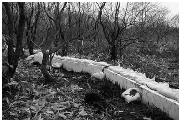
写真 4 汚水を封じ込める遮断壁
