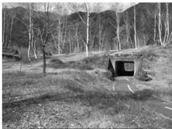
サイクリング道路トンネル作業後
