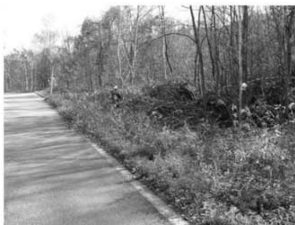
いがや三叉路付近作業中
