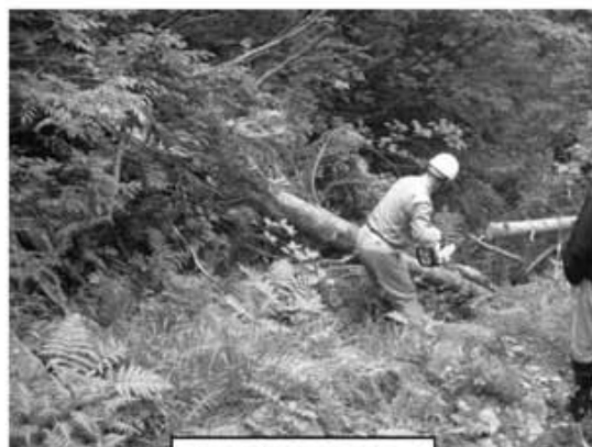
倒木の撤去作業中
