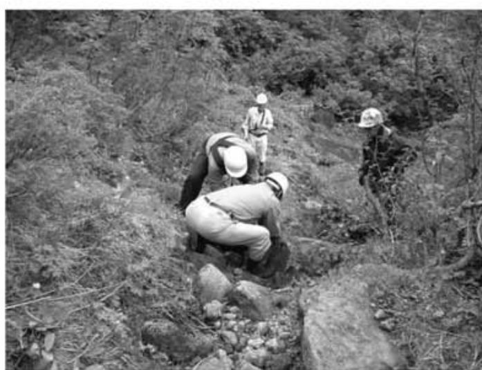
位ヶ原山荘ガレ場作業中
