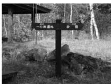
修復交換後 ネイチャープラザ上道標
