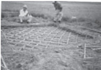
(葦ネット、この後掘削分埋戻し)
