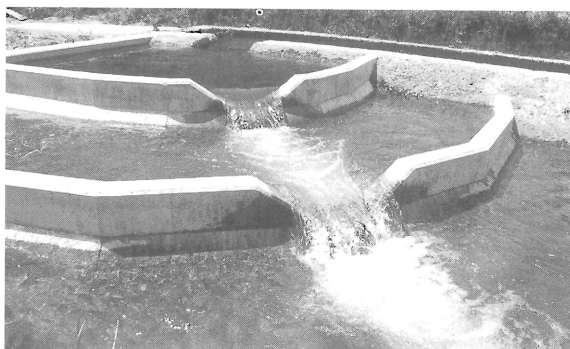
図7 うの松の新魚道はコンクリート製
