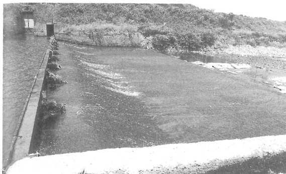
図6 うの松堰 左が堰板
