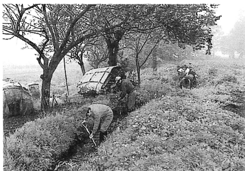
水路での維持管理作業
