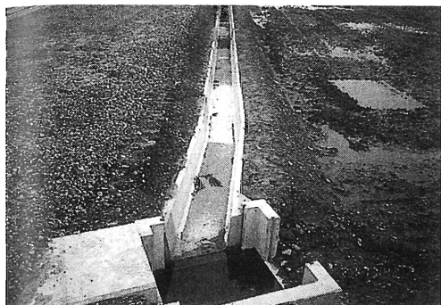
圃場整備後の水路
