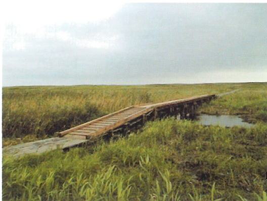
①平成10年9月7日に完成した木道橋
