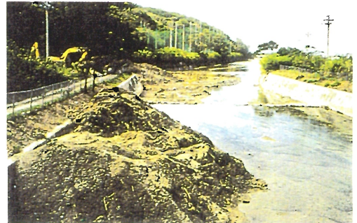
比地川下流 (No. 1) 冬季調査前 (河川改修工事)
