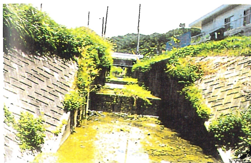
羽地大川下流 (No. 1-③) 三面張り
