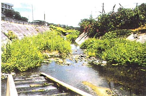
羽地大川下流 (No. 1-②) 三面張り No. 1-①の downstream 側
