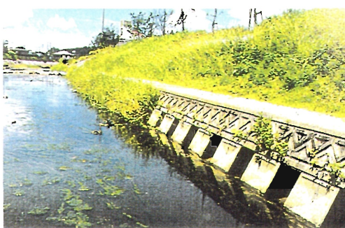
羽地大川下流 (No. 1-①) 親水護岸に造られたエビ穴 (モクズガニが生息している)
