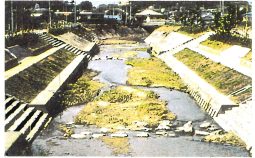
羽地大川下流 (No. 1 -①) 改修後 (近自然工法による親水護岸)
