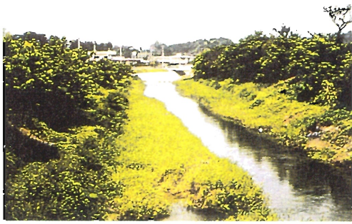
羽地大川下流 (No. 1 -①) 改修前
