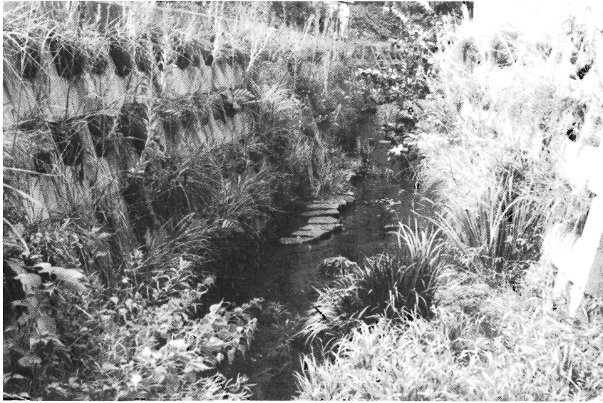
▲生物が棲みやすくした岩戸川の護岸状況
