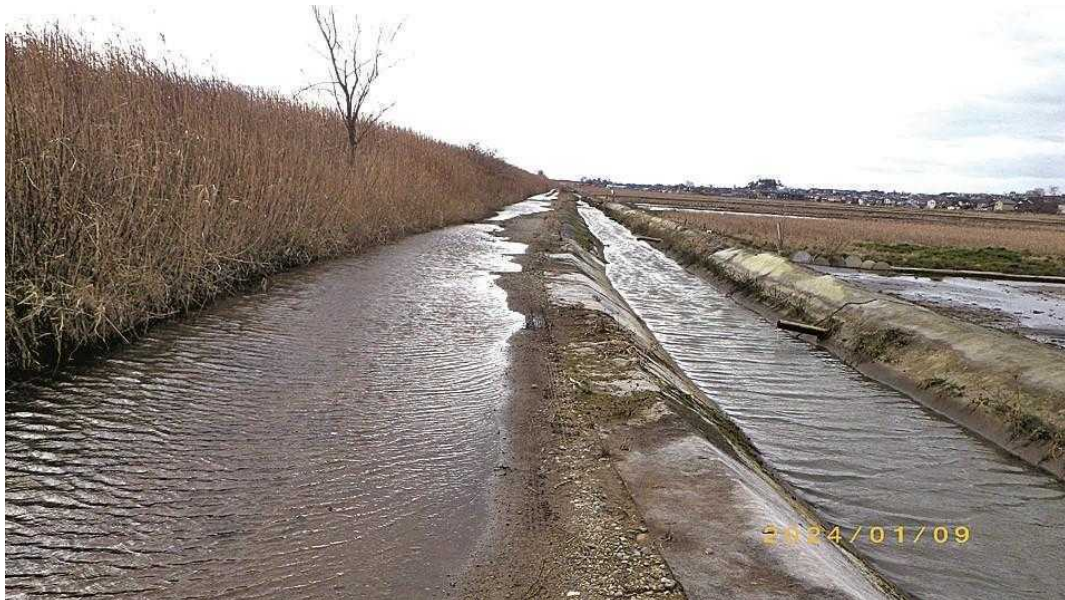
図 管理道路上の溜水。しみ出し，き裂からの噴出による
