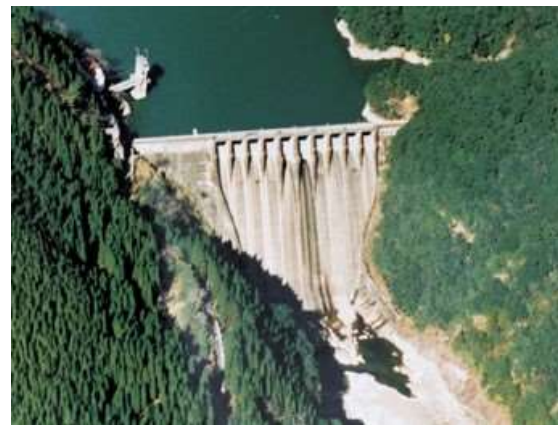
(d)松尾ダム (宮崎県公式 Web サイトより引用)
