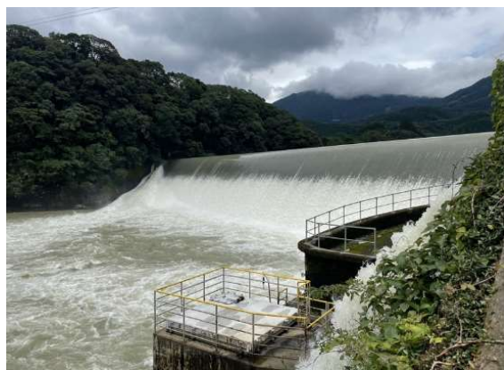
図 4.川原ダム堤体右岸側の沢水
