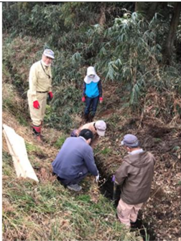
まず既存の腐食した矢板等を取り除く
