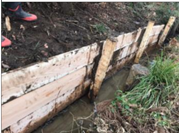
小川の片側の補修が終了
