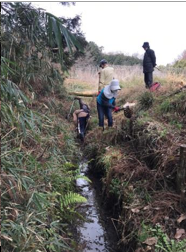
取り除けない杭や矢板もあり工事は難航
