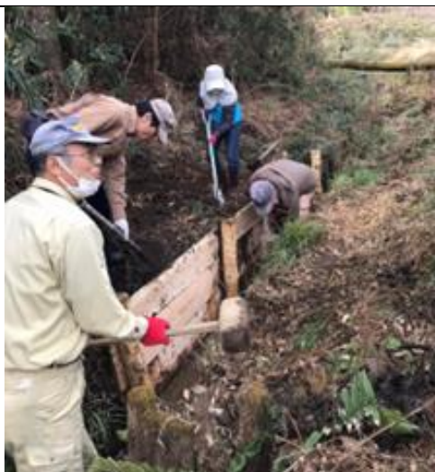
杭を打ち込み隙間を土で埋める
