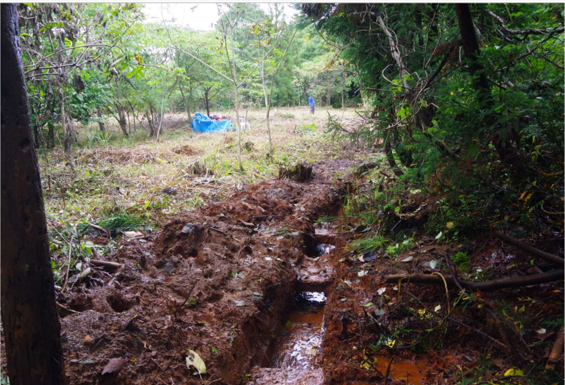
図5 復元中の用水路の様子（撮影 2021 年 10 月）. 小石や粘土質の泥土がぎっちらりと詰まっていて、その除去は困難を極めた。
