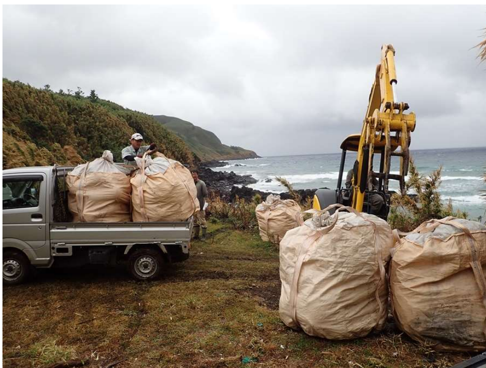
油圧ショベルを使っでの積み込み作業（2020. 10. 17）
