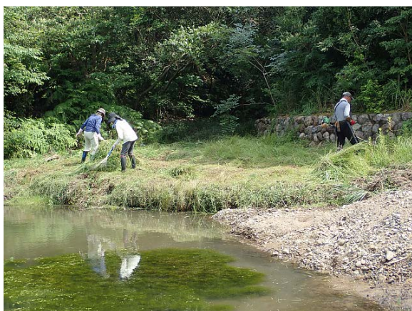
作業の様子 水際の安全性を確保するために、 陸上部の草刈りを同時に行った。
