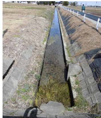
図16 地点2水止めの様子が、かなりの水が流れている。江ざらえは行われていない。
