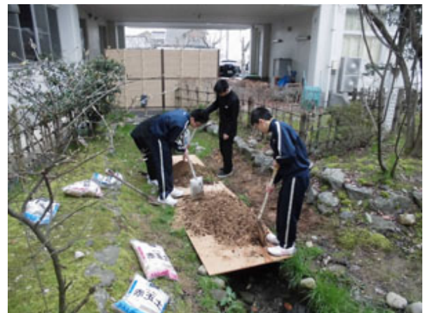
図 53 上陸用斜面の土壌改良
