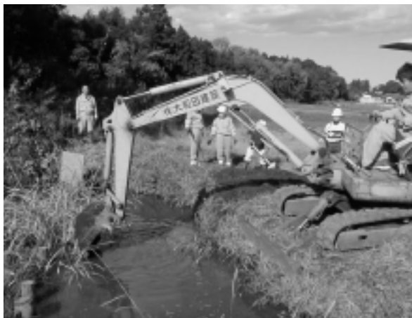
ため池のヘドロ浚渫（2003.11.22） 重機でヘドロを浚渫している様子
