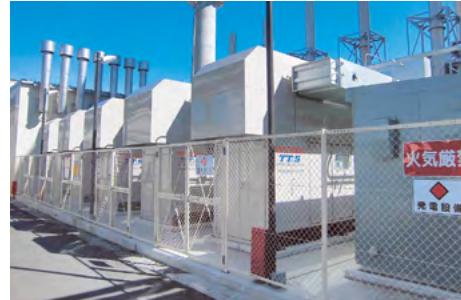
マイクロガスタービン コージェネレーションシステム
