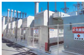
マイクロガスタービン コージェネレーションシステム
