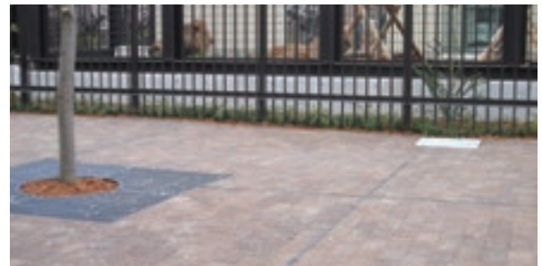
ウィードロックが採用された京都市動物園「もうじゅうワールド」
