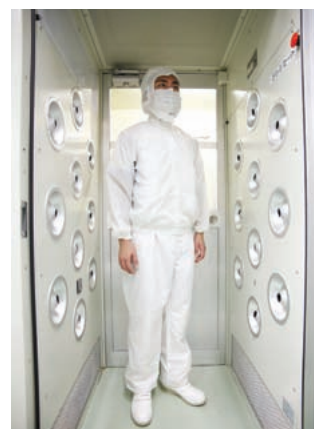
エアシャワー室での異物除去
