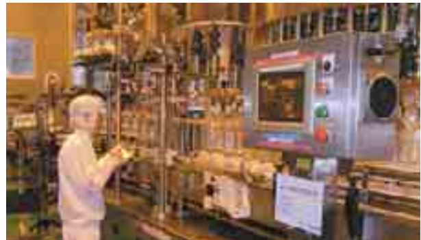
特別清浄区に設置されたクリーンルーム内の充填設備
