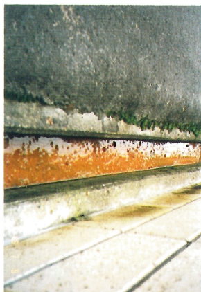
図1 側溝へのマサ砂の撒布状況
