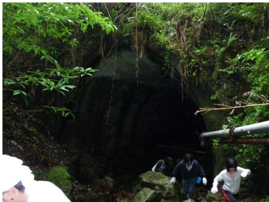
図 4. 奈呂のトンネル入口.
