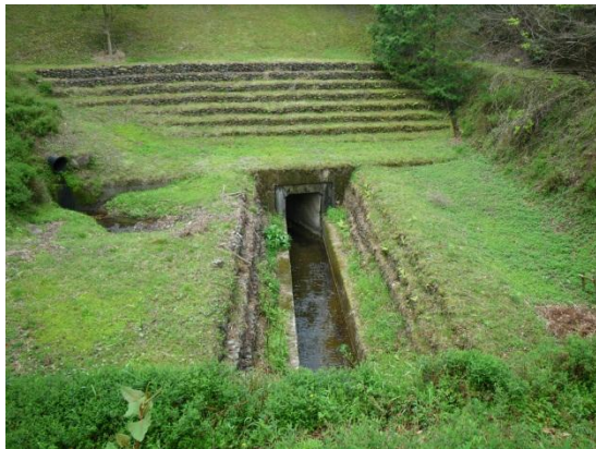
図 2. 用井のボックスカルバート入口.
