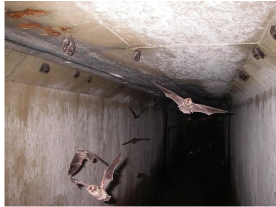
図 3. 用井のボックスカルバート内部.
