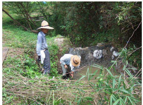
・ビオトープ池への水路の堰の手直し
