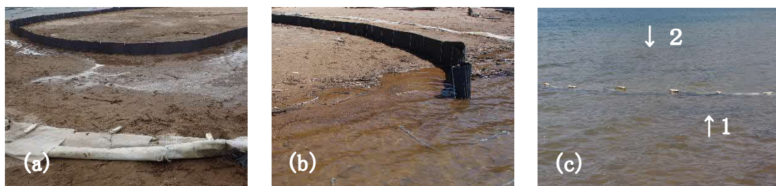
図3. 波板柵の状況。(a)2022年4月下旬の設置後。手前は既存柵。(b)5月上旬。水位回復に伴い波板柵が破損した。奥は既存柵。(c)7月上旬の再設置後。矢印1は既存柵、矢印2は波板柵。
