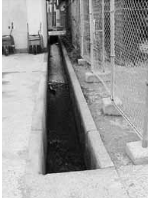
(写真① 平成16年5月の用水路の様子)
