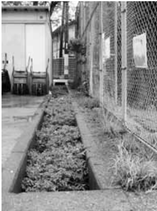
(写真⑫平成17年4月の用水路の様子)
