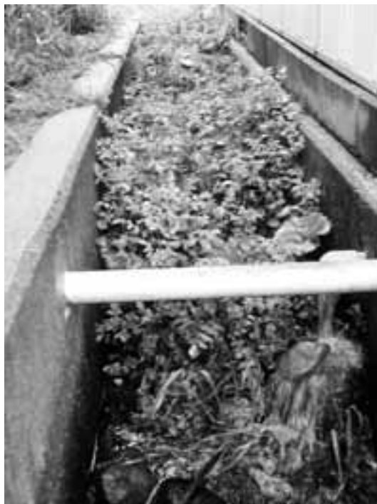
(写真⑭ 地下水の汲み上げの様子)
