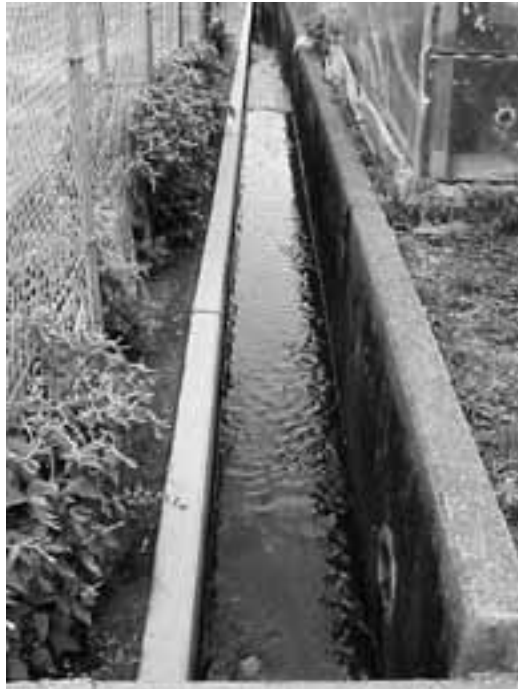
(写真② 平成16年5月の用水路の様子)
