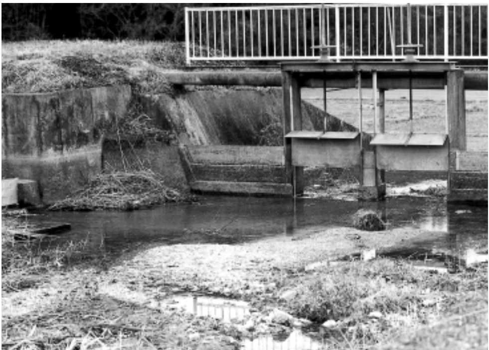
写真10 池の横を流れる法華山谷川。鉄板で堰がされると、池の水位が75cm上昇する。
