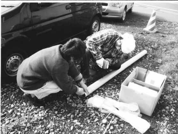
調査機器設置準備 平成16年7月1日
